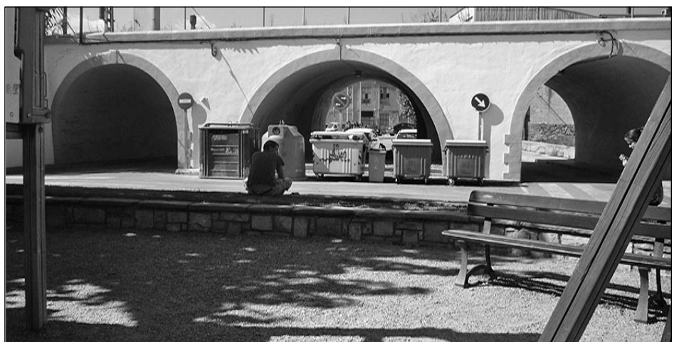
El Pont que va substituir el terraplè que havien projectat el enginyers dels Ferrocarrils Catalans.
